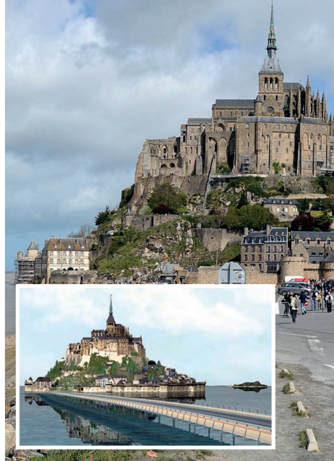
Straßendamm und Parkplatz werden bald abgerissen werden, und an ihre Stelle tritt eine elegante Stelzenbrücke, die auf V & M TUBES Rohren steht. (Virtuelle Darstellung von Image / MG Design)
